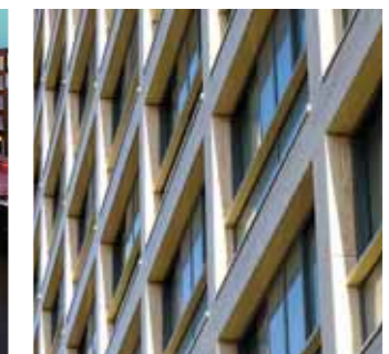
HOUTRUST, DEN HAAG 116 APPARTEMENTEN + PARKEERGARAGE + COMM. RUIMTE
